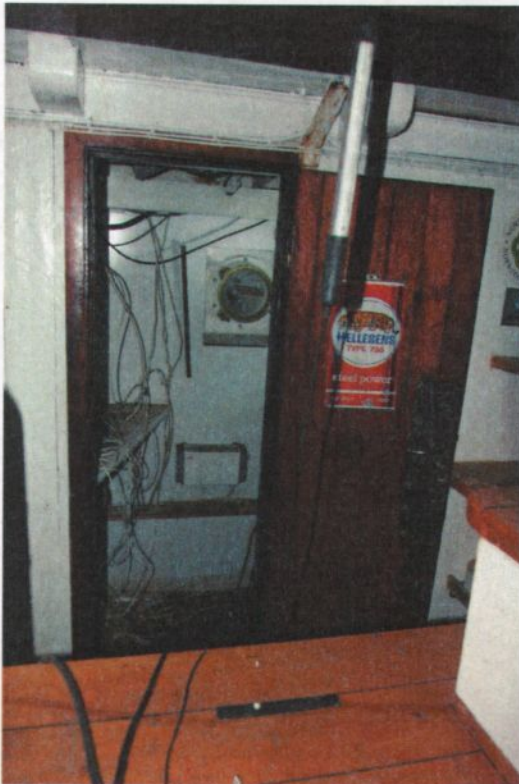
Tidligere billettkontor, under restaurering 2010
