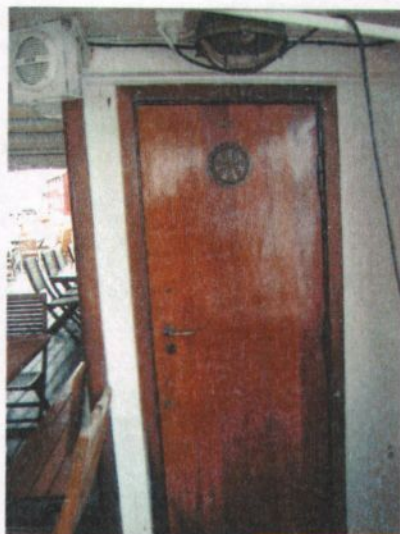
Dør merket herretoalett
